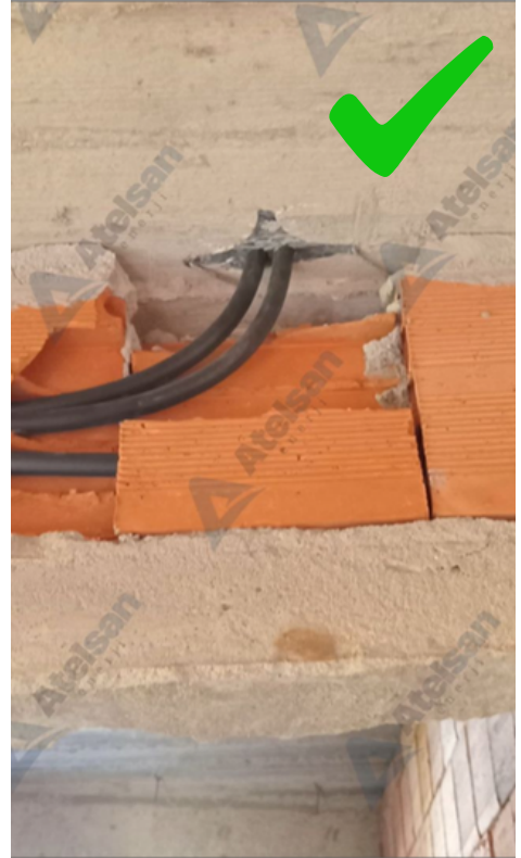
Şekil 4.3 : Kiriş buatı kullanılan bir tesisatta hem güvenlik artar hem de işçilik maliyeti azalır
