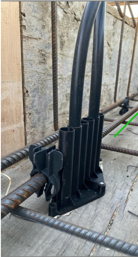
Şekil 3.3 : Kiriş buatı kiriş etriyeleri arasına montajlanmış
