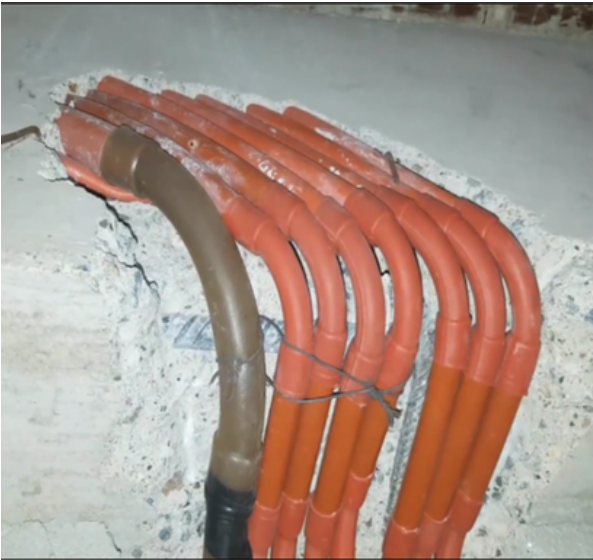
Şekil 2.3: Geleneksel yöntemde buat bile konulmadan sadece boru eki ile yapılmış planşe işçiliği
